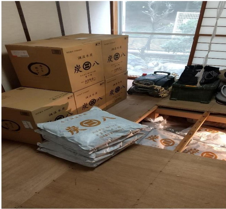
床下用炭八 設置中 (和室北側)
