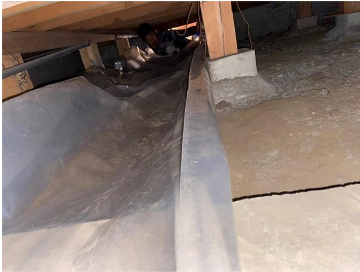
フィルムシート設置中
