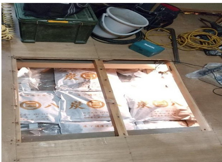
床下用炭八 設置中
