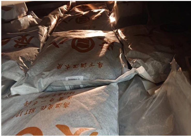
床下用炭八 設置中
