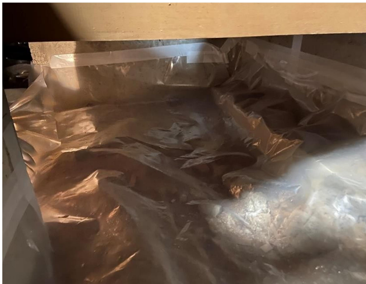
フィルムシート設置完了
