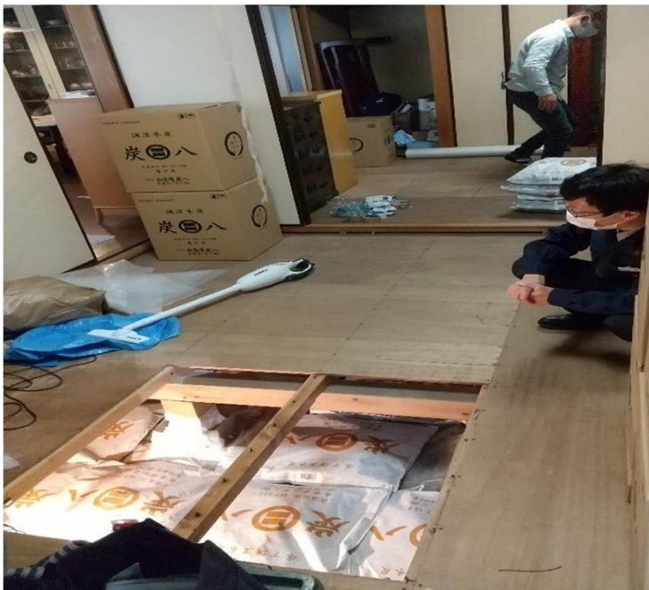
床下用炭八 設置中
