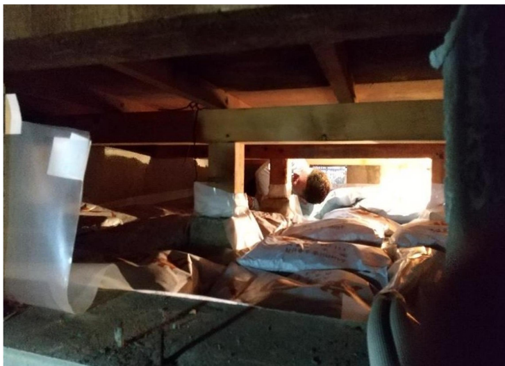
床下用炭八 設置中
