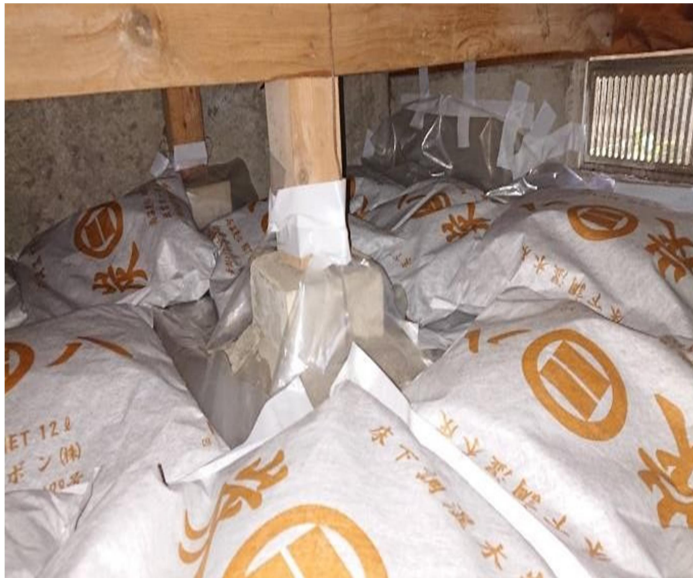
床下用炭八 設置完了
